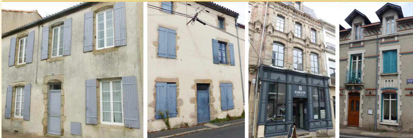
Quelques restaurations de maisons anciennes à Bressuire
