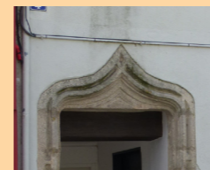
Lintheau de porte à accolade, vestige d'une maison ancienne ou élément récupéré sur le Château
