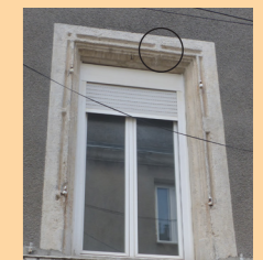
Encadrement de fenêtre Renaissance réemployé. La trace du meneau central n'est pas au milieu du lintheau
