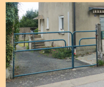
Portail réalisé par les habitants-bâisseurs de la Cité des Castors
