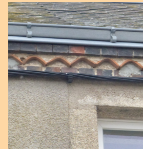
Génoise en tuiles et briques, qui rappelle la présence de briquetteries à Bressuire au XIX e siècle
